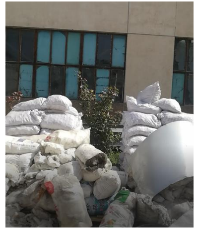
拆除后遗留废物
