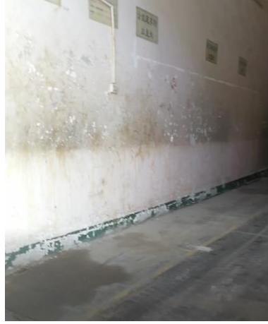
二分厂固废暂存
